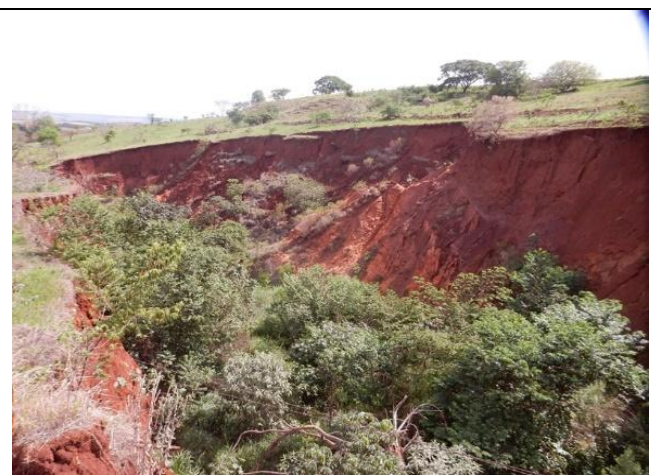
Figura 13 - Detalhe da vegetação no interior do eixo principal da erosão. Arquivo - 2018.
