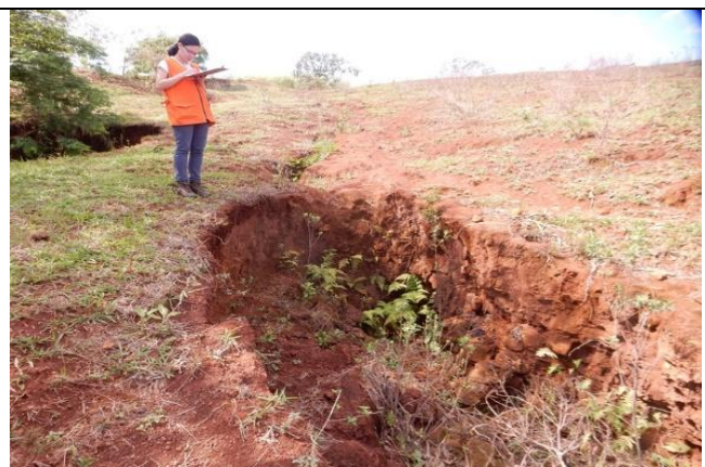
Figura 10 - Erosão do tipo ravina em área de pastagem, paralela à erosão principal. Arquivo - 2018.
