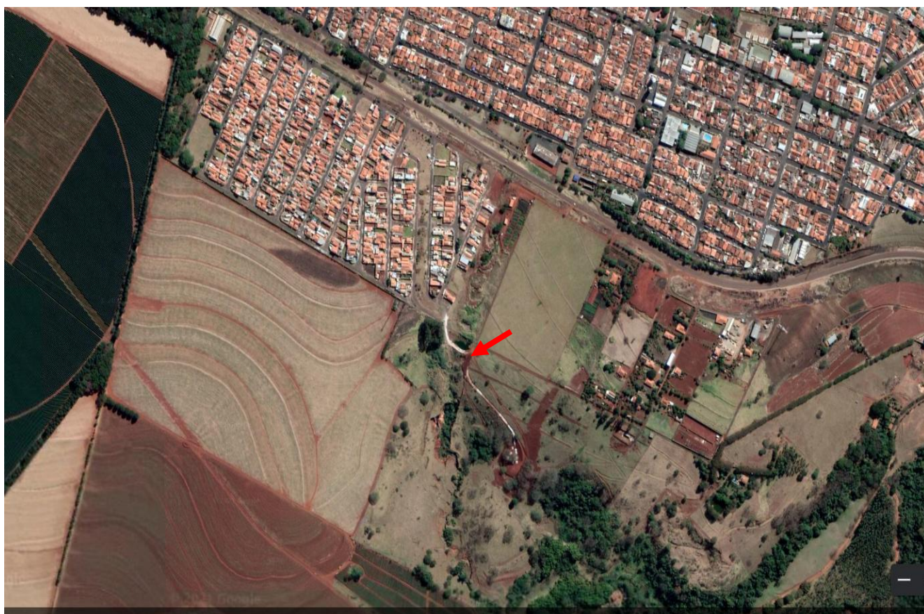
Figura 02 – A seta indica a posição e o início do processo erosivo.
