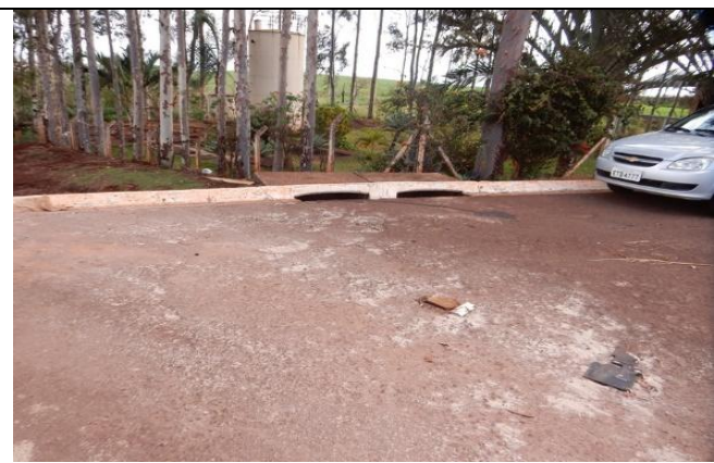
Figura 07 – Final do Bairro Jardim Botânico no início da área rural e ao fundo Estação de Bombeamento de Esgoto. Arquivo – 2018.
