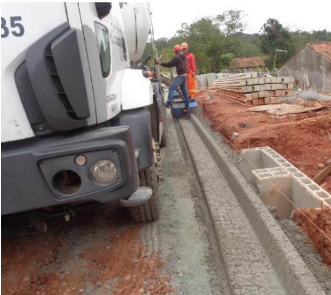
Foto ilustrativa de execução de guia e sarjeta conjugados de concreto, moldada "in loco", com máquina extrusora sendo abastecida com concreto usinado
