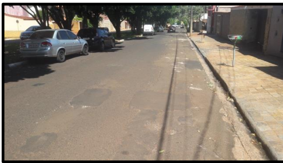
Foto 05: Vista de trecho da Av. Salvador Pagano
