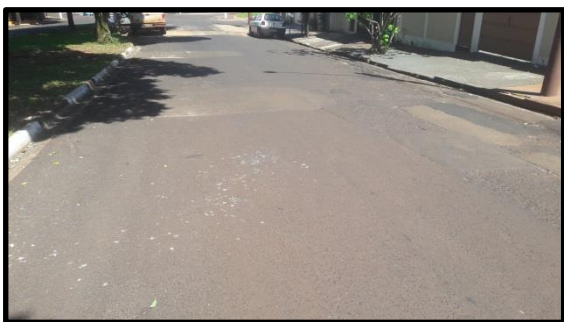
Foto 03: Vista de trecho da Av. Salvador Pagano
