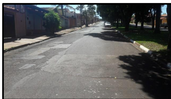
Foto 02: Vista de trecho da Av. Salvador Pagano
