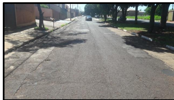
Foto 04: Vista de trecho da Av. Salvador Pagano
