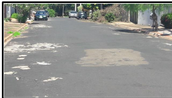
Foto 02: Vista de trecho da Rua: Aristides da S.Ramos
