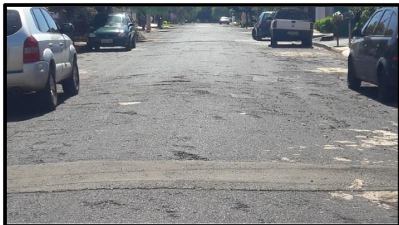
Foto 01: Vista de trecho da Rua: Aristides da S.Ramos
