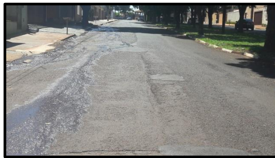
Foto 06: Vista de trecho da Av. Salvador Pagano
