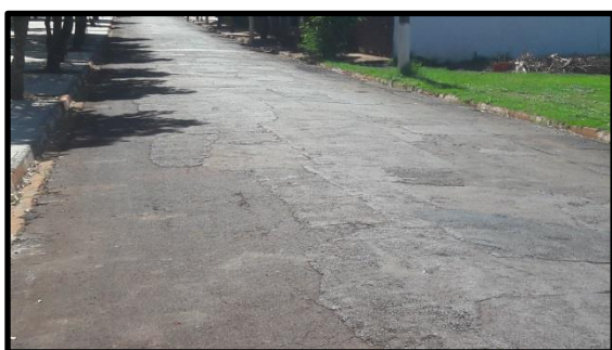
Foto 01: Vista de trecho da Av. Salvador Pagano
