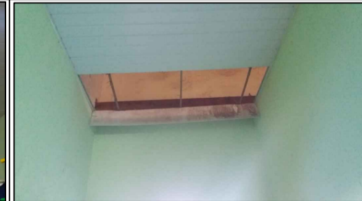
FORRO DA ÁREA DE CIRCULAÇÃO SITUAÇÃO ATUAL
